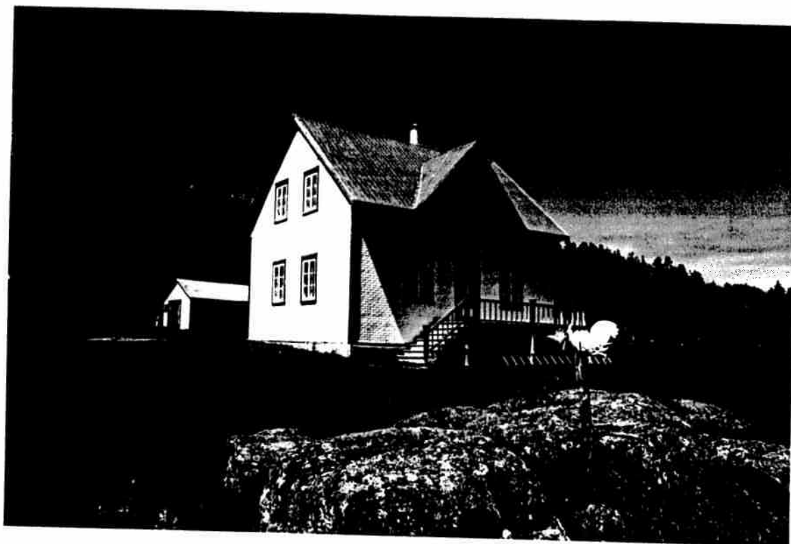
Toit à lucarne-pignon Lot 10 p. N° négatif C - 89 - 01 - 28 (35)
