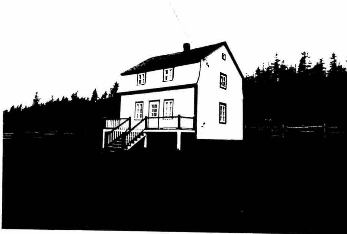
Toit à la Mansard Exemple-type. Lot #24 p. N° négatif C - 89 - 03 - 03 (35)
