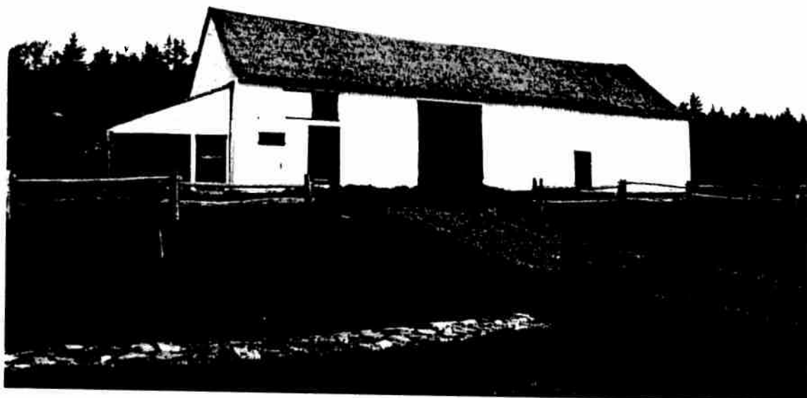
Grange-étable avec toiture à deux versants et accès de plain-pied.
